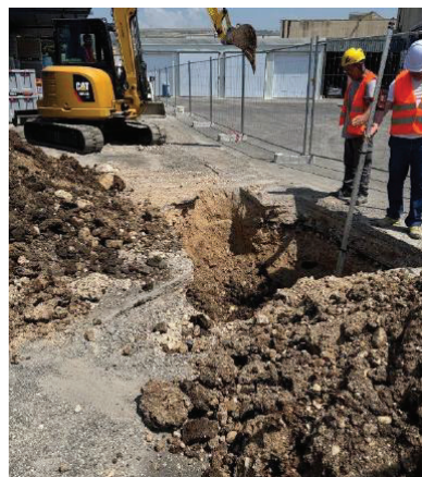
Fig.1 Esecuzione di scavo per alloggio vasca
