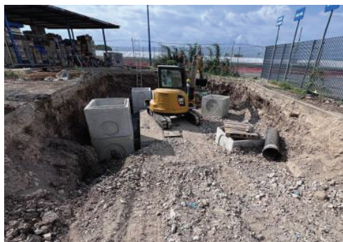
Fig. 2 Scavo alloggio vasca e pensionamento sopralzi
